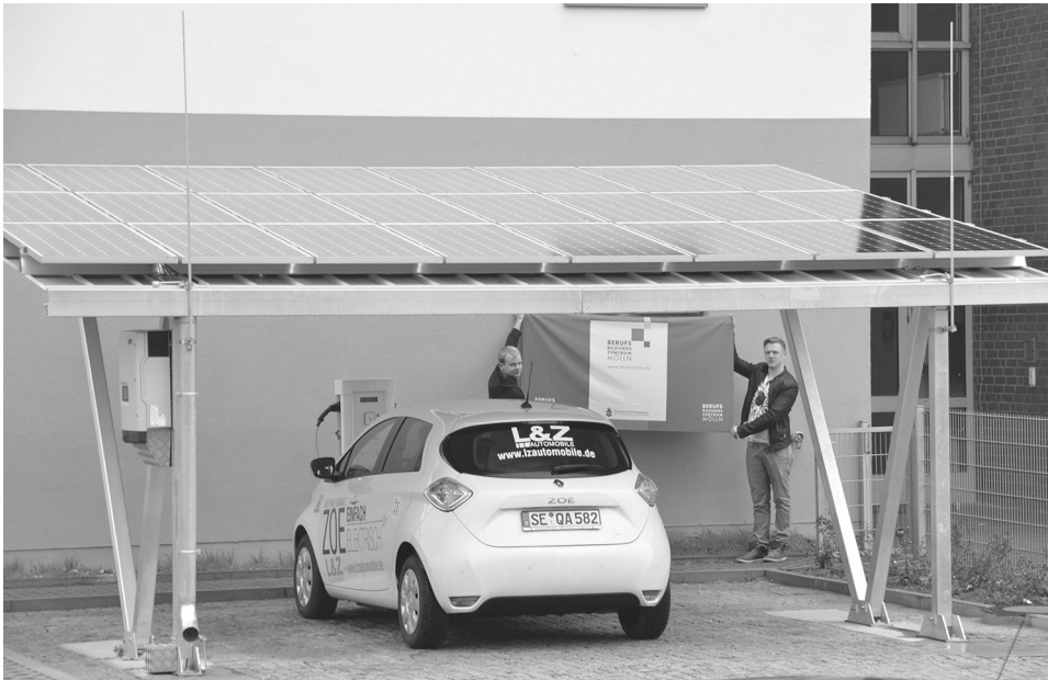
Abb. 6: Carport mit der Fotovoltaikanlage des BBZ Mölln
