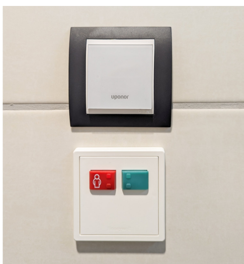
Abbildung 5: Starke Kontraste zwischen Lichtschalterrahmen und Taster berücksichtigen speziell die Bedürfnisse von Menschen mit Seheinschränkungen. (Beschreibung siehe Abbildungs- und Tabellenverzeichnis mit Alternativtexten)
