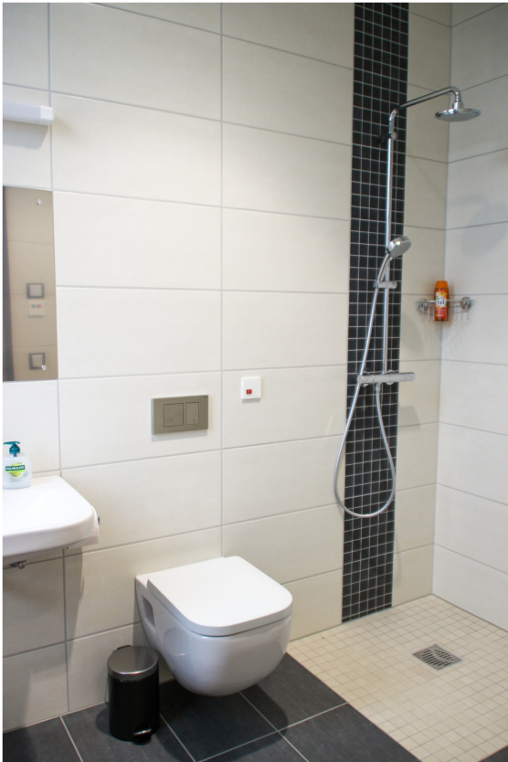
Abbildung 7: Kontrastreiche Gestaltung der Wandfliesen in einer Sanitäranlage (Beschreibung siehe Abbildungs- und Tabellenverzeichnis mit Alternativtexten)
