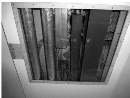
Abb. 2: Leitungsverlegung in abgehängter Decke Abb. 3: Passivhaustauglicher Einbau einer Tür
