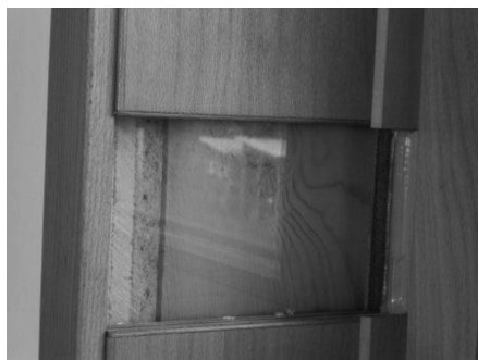
Abb. 2: Leitungsverlegung in abgehängter Decke Abb. 3: Passivhaustauglicher Einbau einer Tür
